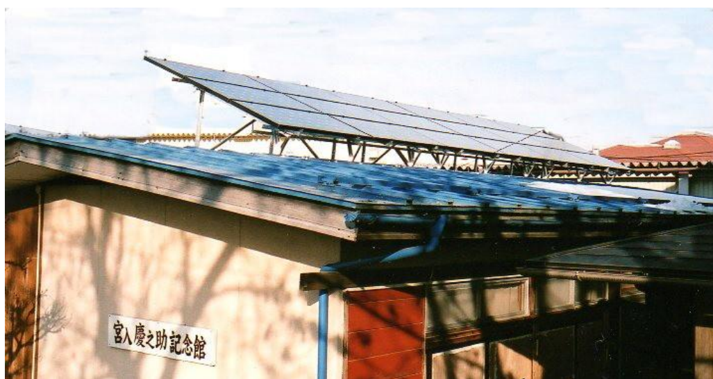
(取り付けが完了した太陽光パネル)
